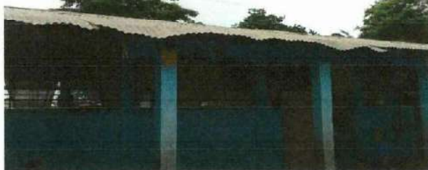
Foto 5: Se observa deterioro de las láminas de las aulas.
